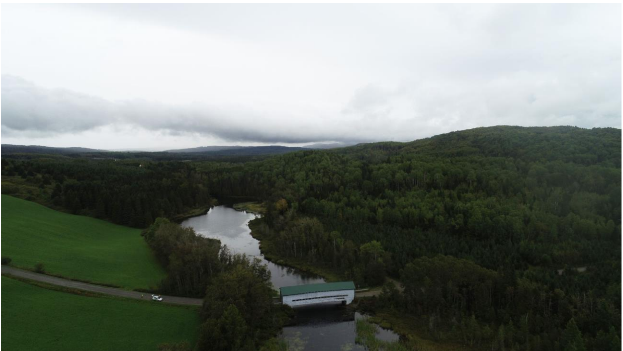
Fig 40. Vue aérienne du pont vers le nord-est [2020-09-09 P-06466 Draveurs IPS-Photo AAC_DJI_0069.JPG]
