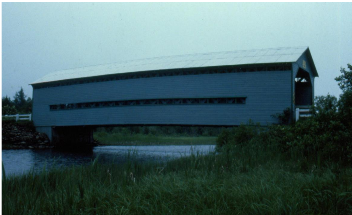
Fig. 11. Cette photo de 1984 montre que lors des travaux de 1982, la tôle de la toiture a été remplacée. Photo : André Groossens via pontscouverts.com
