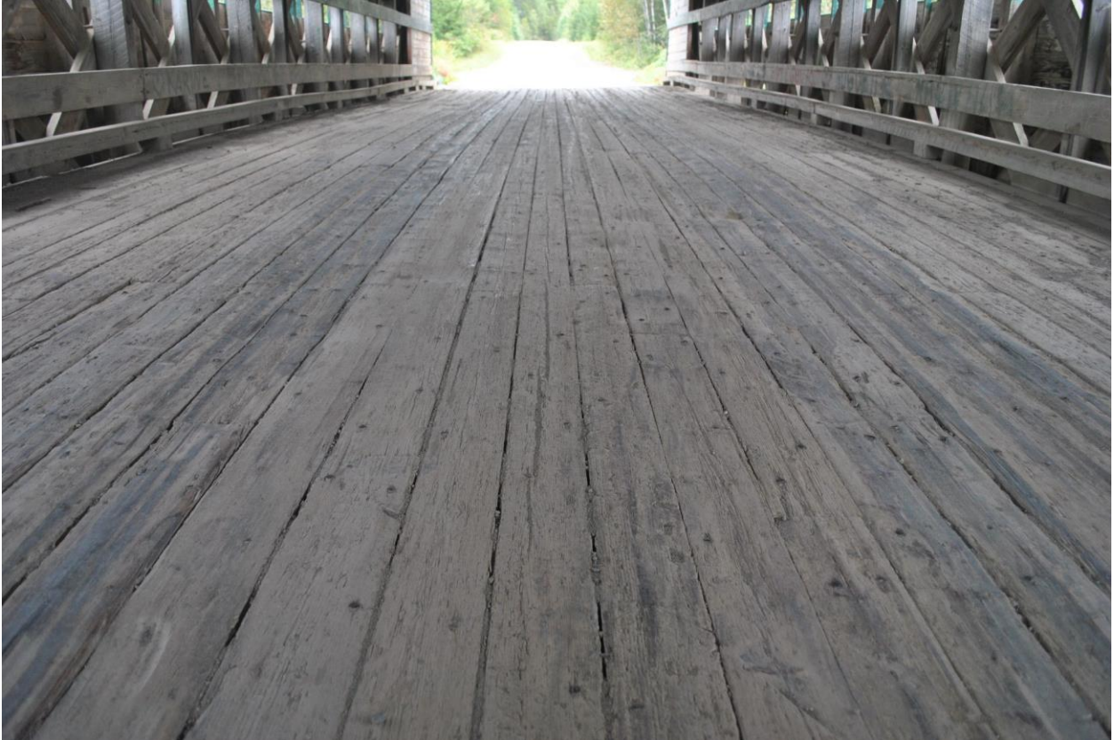
Fig. 29. Surface de roulement, chasse-roues, garde-corps intérieur en bois et mains courantes. [2020-09-11 Pierre-Carrier Saint-Ulric IPS-Photo ERR_DSC_0587.JPG]
