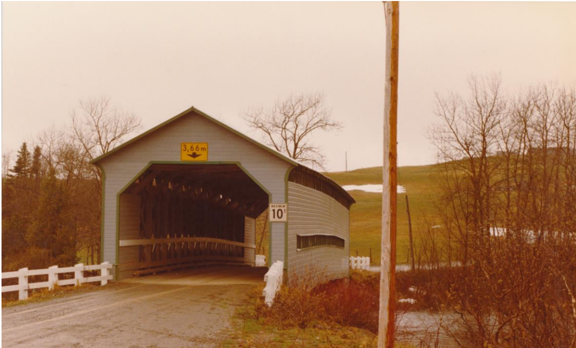
Fig. 10. Cette photo provenant d'une inspection menée par le ministère des Transports en 1982 montre que le pont semble avoir fait l'objet d'une restauration. Le portique et le lambris semblent être renouvelés et la peinture, récemment appliquée. Des panneaux de signalisation ont été apposés sur le portique. Ministère des Transports du Québec, Dossier P-06466 : 1982-05-10 P-06466 Photo pont couvert Inspection DS.png
