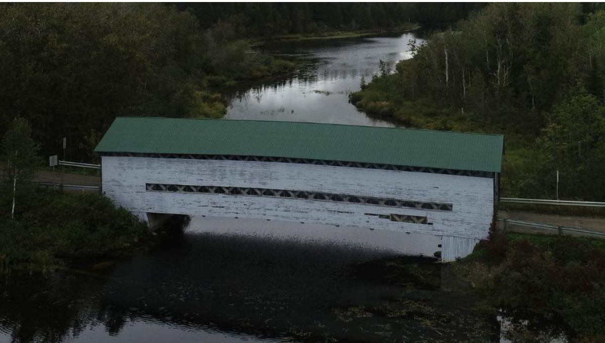
Fig. 28. Détails de l'ouvrage d'art, côté sud (amont) [2020-09-09 P-06466 Draveurs IPS-Photo ERR_DSC_8083.JPG]
