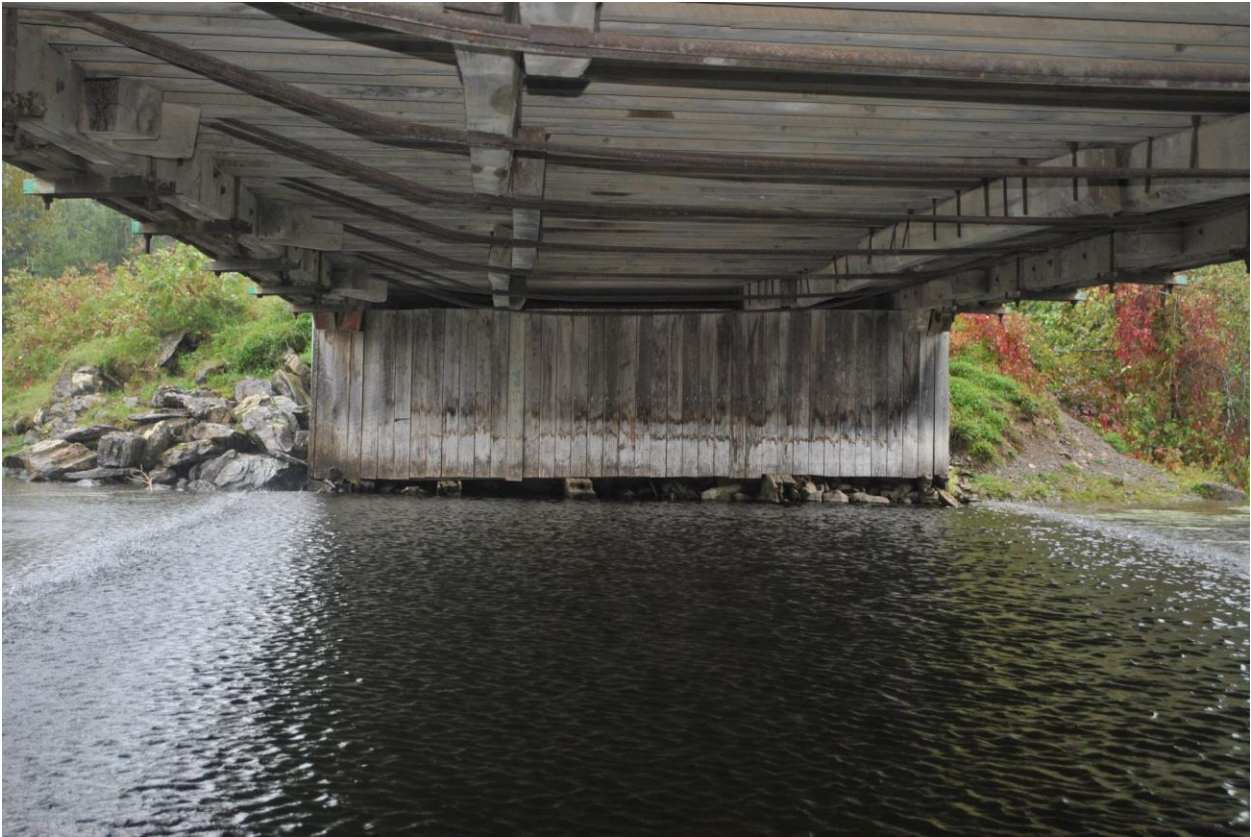
Fig. 31. Dessous du tablier, cordes inférieures et enrochement de la culée ouest. On voit le système de renforcement du platelage ajouté dans les années 1950. [2020-09-09 P-06466 Draveurs IPS-Photo ERR_DSC_8018.JPG]
