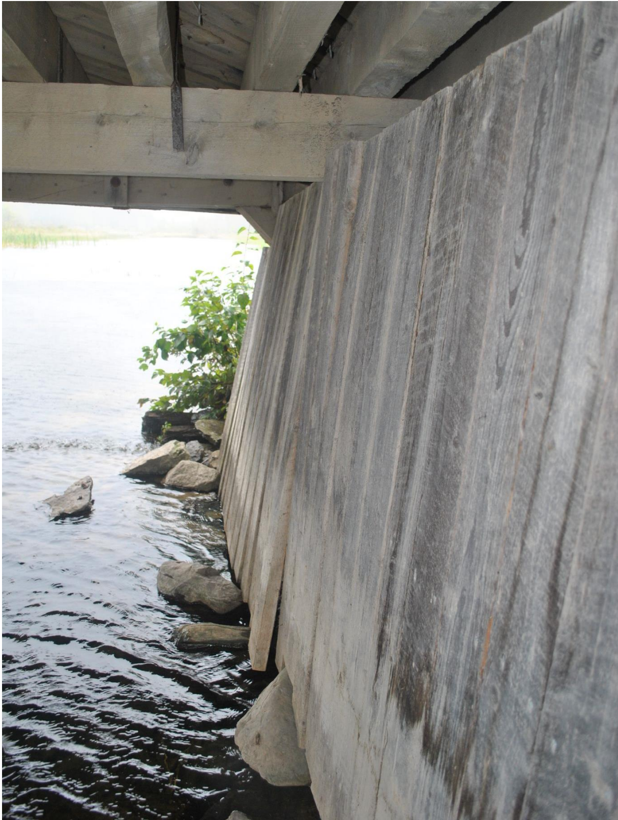
Fig. 32. Le caisson à claire-voie lambrissé, côté est. [2020-09-09 P-06466 Draveurs IPS-Photo ERR_DSC_0627.JPG]
