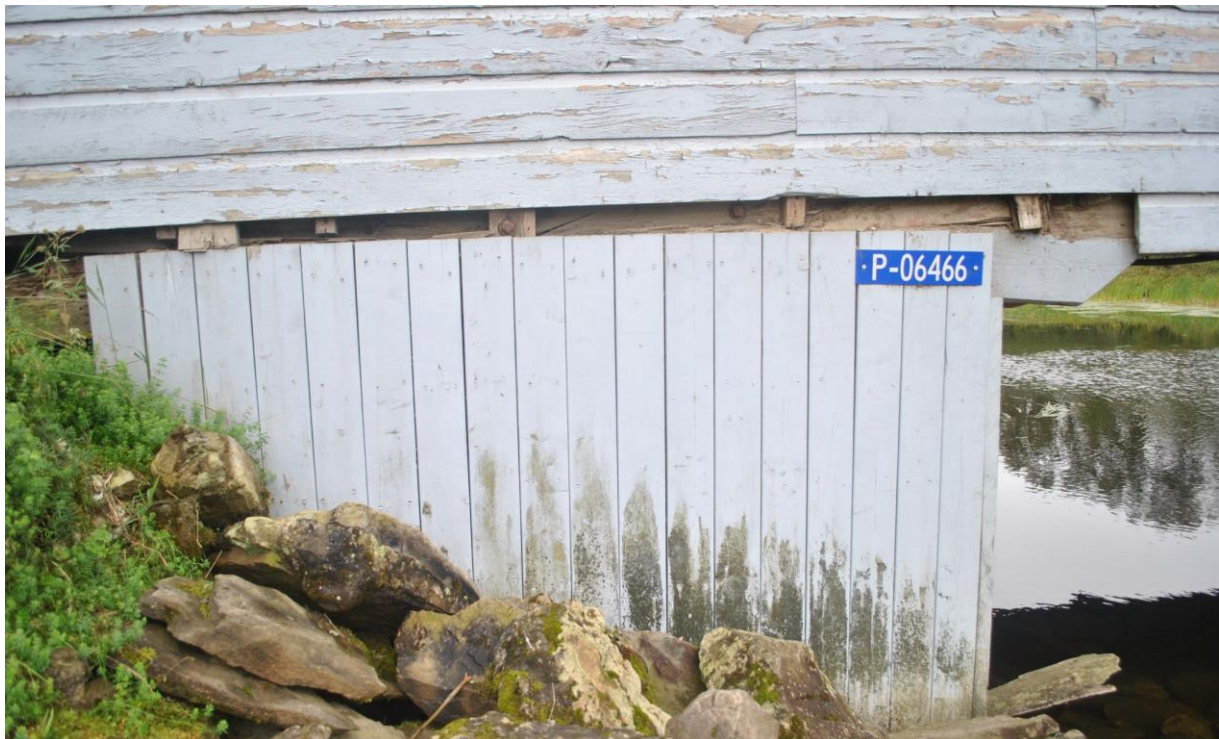
Fig. 36. Affichage numérique, sur la culée de type caisson à claire-voie lambrissé côté ouest du pont [2020-09-09 P-06466 Draveurs IPS-Photo ERR_DSC_0605.JPG]
