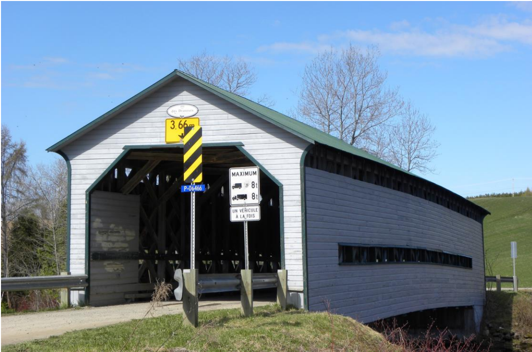
Fig. 16. On voit sur cette photo du pont prise en 2007 que les garde-corps en bois marquant les travées d'approche ont été remplacés par des glissières de sécurité GTOG. La charge maximale du pont a aussi été réduite à 8 tonnes. Photo : Pascal Conner via pontscouverts.com
