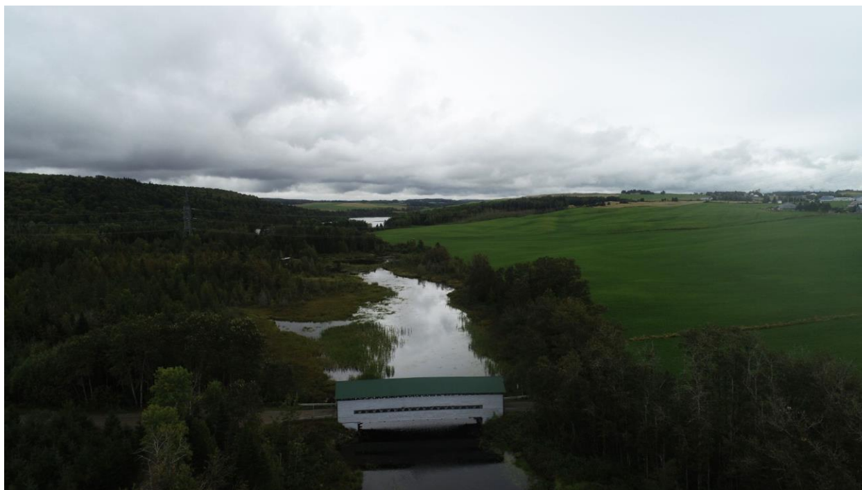
Fig 22. Vue aérienne du pont vers le sud-est, on voit les terres agricoles du côté est et les montagnes forestières du côté ouest [2020-09-09 P-06466 Draveurs IPS-Photo AAC_DJI_0130.JPG]
