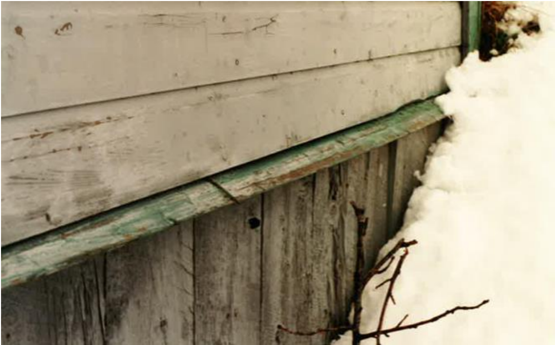
Fig. 13. Sur cette photo de 1991, on remarque la présence de jets d'eau au-dessus des culées de type caisson à claire-voie lambrissé. Tiré de Jean, Régis. Évaluation patrimoniale des ponts couverts de la Municipalité régionale de comté de Rimouski-Neigette. Québec, Ministère de la Culture, 1990. p.46.
