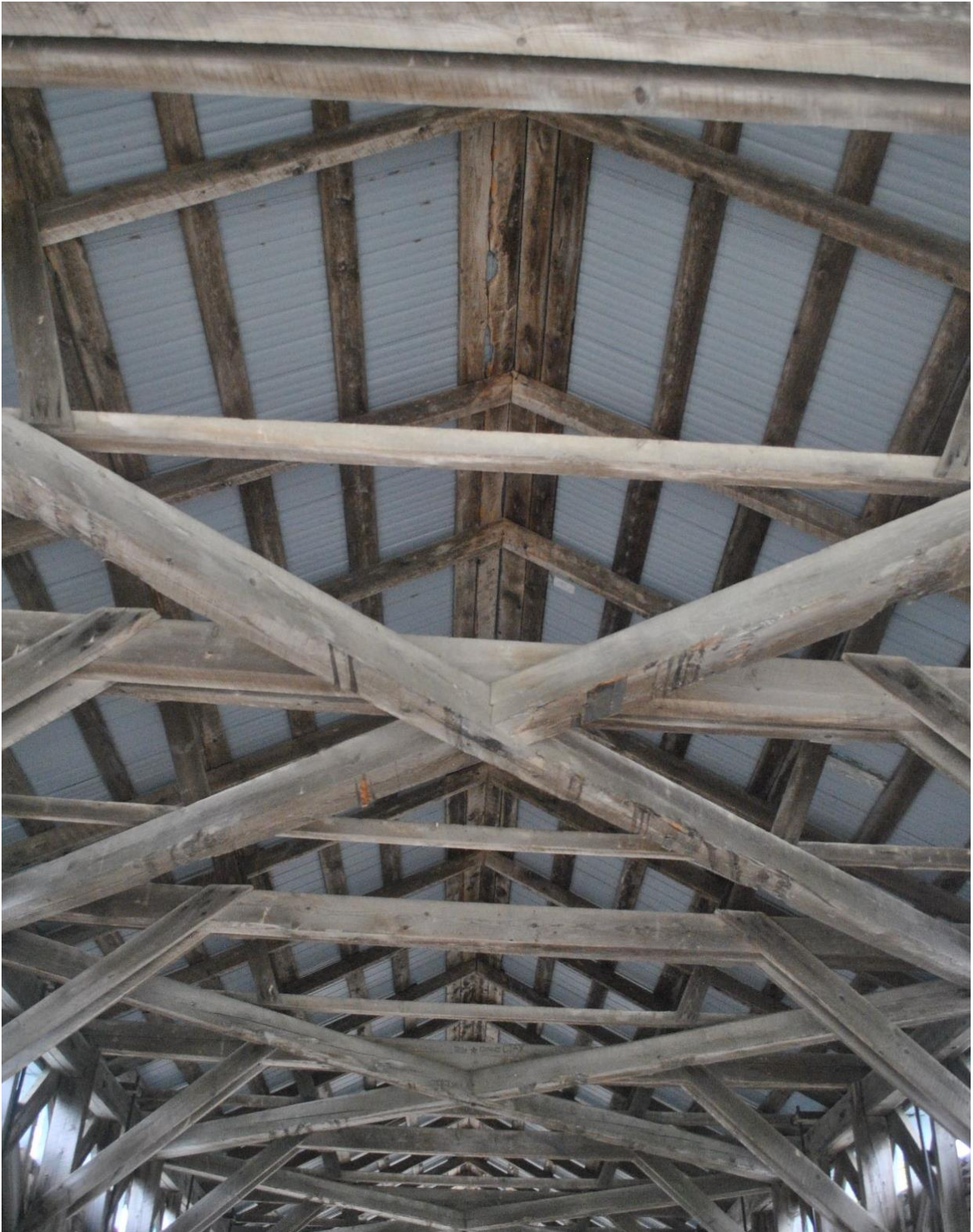
Fig. 30. Contreventements supérieurs, charpente du toit et couverture de tôle.[2020-09-09 P-06466 Draveurs IPS-Photo ERR_DSC_0583.JPG]
