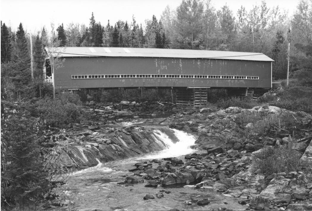
Pont de l'Écluse (61-17-04), rivière du Ha! Ha!. Une structure entièrement lambrissée de tôle.
