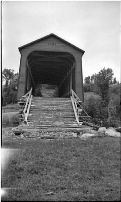
Du remblai remplacera ces approches en bois temporaires. Photo BAnQ, fonds MCC : Irenée Beaudet 1944, E6,S7,SS1,P20605
