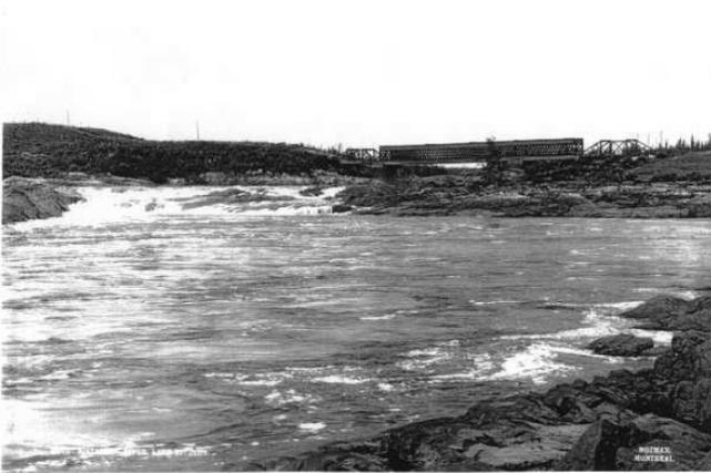
Le premier pont est érigé en 1893 et des photographies du studio Notman montrent une ferme à treillis non lambrissée flanquée de chaque côté par une approche construite sur le modèle des fermes à poinçons doubles. Les culées et les piliers sont constitués de cage en bois et lambrissées face au courant. Le site choisi pour cette traverse est pour le moins tumultueux mais les bases du pont sont assises sur le roc.
