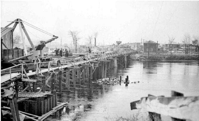
Le pont neuf érigé à quelques mètres de l'ancien. Les débris d'un pilier émergent de l'eau. Au premier plan, à droite, le garde fou calciné du pont couvert ne mène nulle part, devenu inutile.
