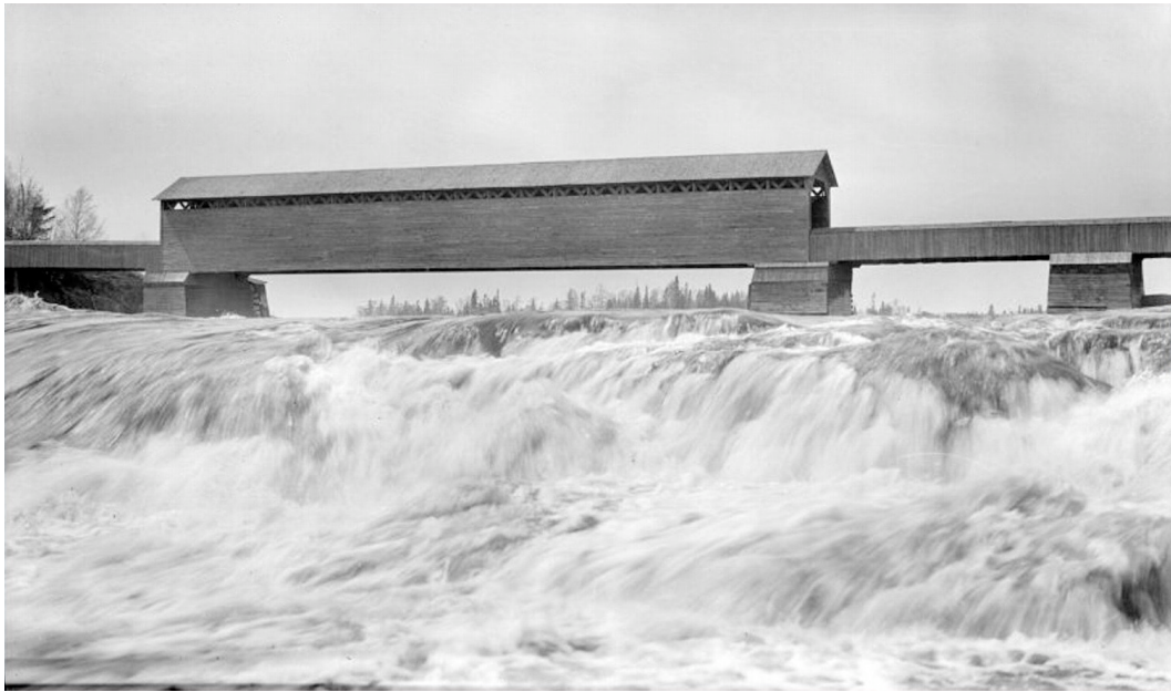
Le pont Price (61-60-30) en 1920. Outre la travée principale couverte, la structure comporte 3 petites travées mi-hauteur lambrissées. Photo : BAnQ E57,S44,SS1,PB9-83.
