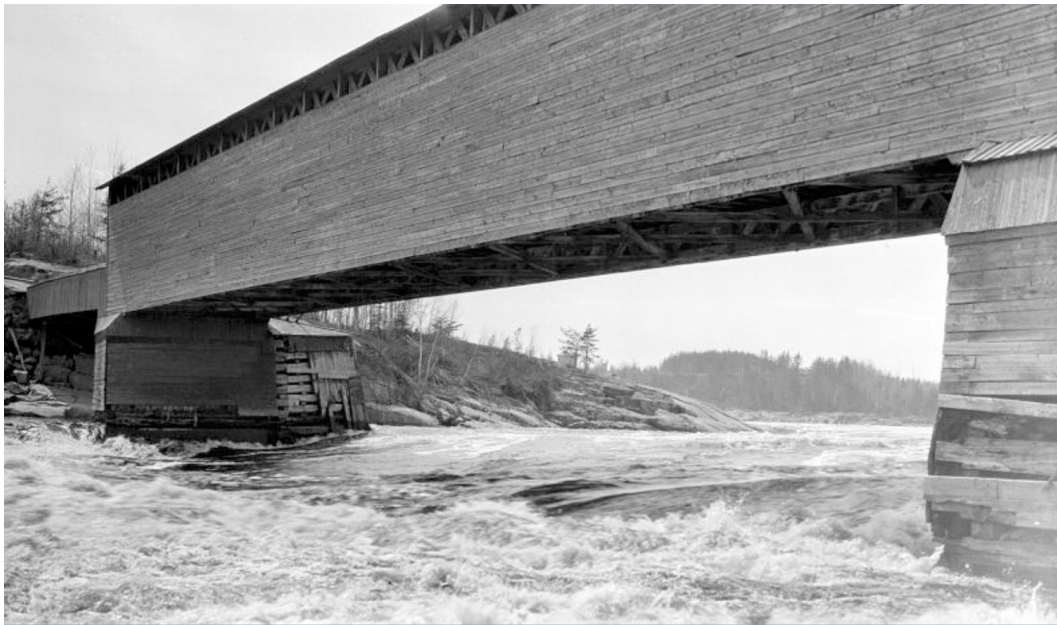
Une travée de type Town élaboré dont la portée se mesure avec audace à la force du courant. Photo : BAnQ E57,S44,SS1,PB9-88.
