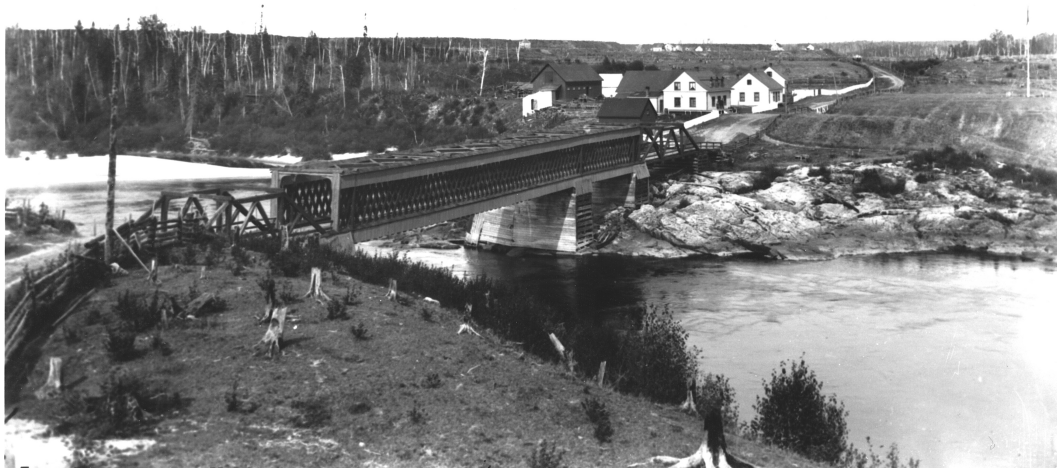
Pont Michel-Louis, près de la ferme Scott et de l'établissement des Trappistes. Photo : AnC PA-24312.
