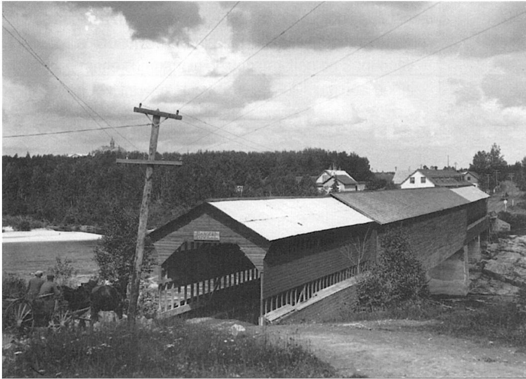
L'aspect du pont Price en 1928. La grande travée est demeurée intacte, mais les petites travées mi-hauteur sont coiffées d'un comble appuyé sur des montants verticaux. Photo : Studio Chabot, Roberval.
