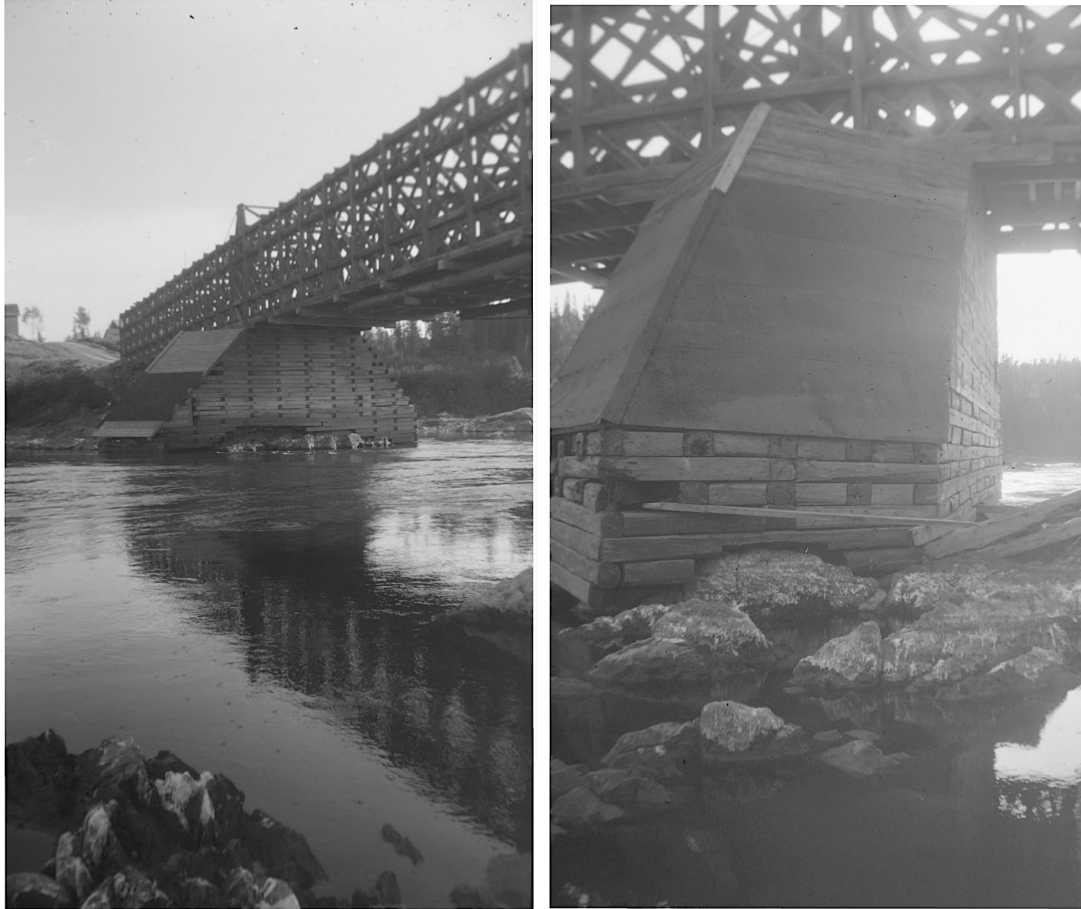
Le pont sur la rivière Bell à Rapide-des-Cèdres, avec ses piliers massifs en bois appuyés sur les rochers. Photos : Serge Godbout, 1950. BAnQ E6,S7,SS1,P81819 et P81932.
