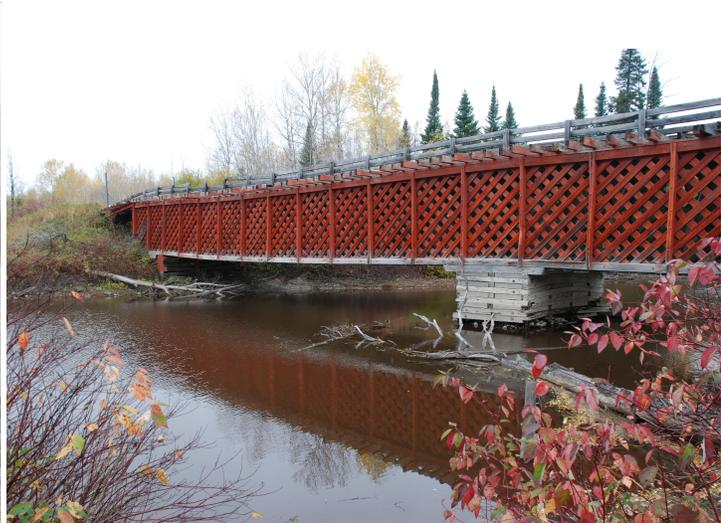
Vraisemblablement écroulé sous une surcharge, le pont a été remplacé vers 1951 par une structure à tablier supérieur de type Town élaboré, laquelle existe encore. Photos : Gérard Ouellet, 1950. BAnQ E6,S7,SS1, P81274 ; Gaétan Forest, 9 octobre 2016.
