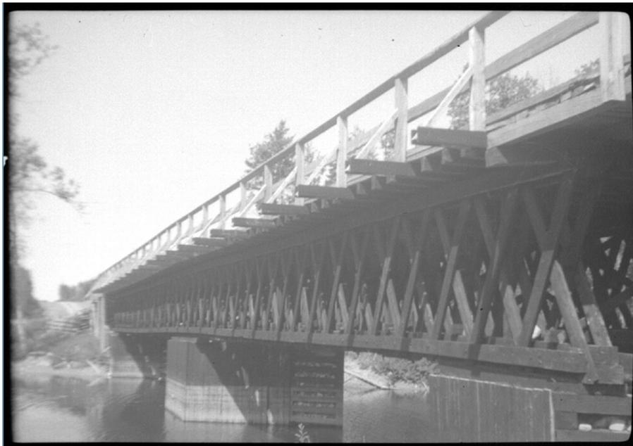
Pont sur la rivière Davy : un tablier supérieur supporté par des poutres de type Warren à double intersection. Photo : C. Léveillé, 1941. BAnQ E6,S7,SS1, P2158.
