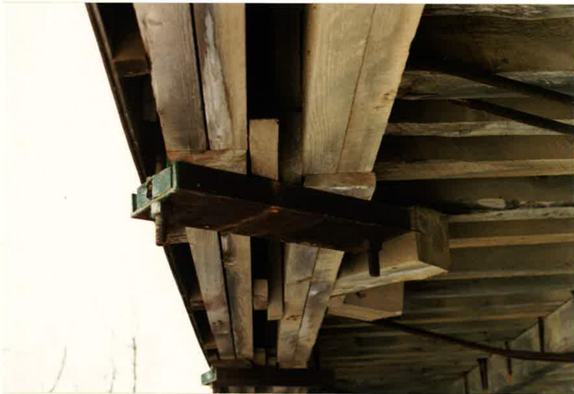
Pièces de métal sous la corde inférieure et tiges de tension d'acier.
