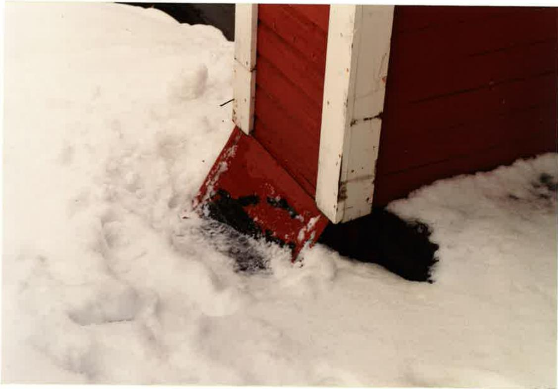
Au bas des jambages, une légère inclinaison forme un jet d'eau et éloigne l'eau de pluie.
