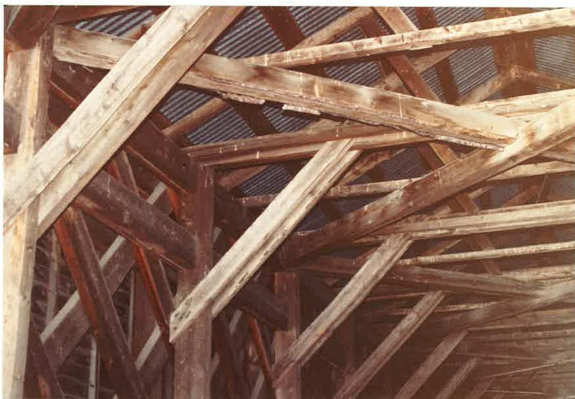
Structure de la toiture. La tôle repose sur des pannes clouées aux chevrons.
