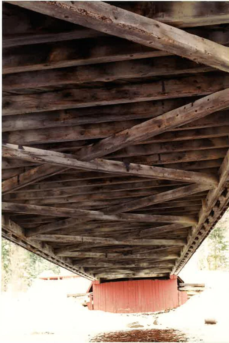
Pont de Trinité-des-Monts. Vue sous le tablier : des croisillons, posés entre les cordes inférieures, assurent la stabilité latérale.
