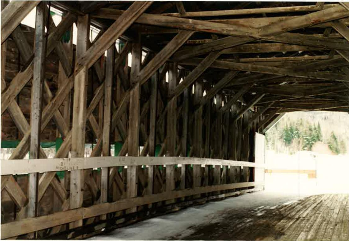
Structure des murs : treillis de madriers, poteaux verticaux et tiges de tension en acier reliant les cordes supérieures et inférieures.
