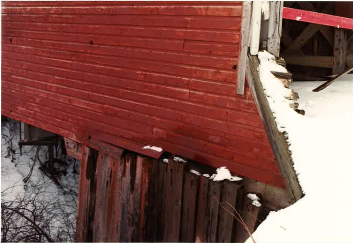
Une inclinaison, au bas des portiques, forme un jet d'eau et éloigne l'eau de pluie au-delà de la culée située juste au-dessous.
