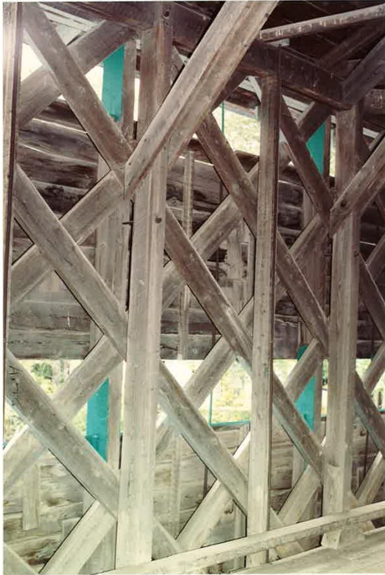
Structure des murs, pont de Saint-Anaclet : treillis de madriers redoublés de poteaux verticaux et renforcés de tiges métalliques qui réunissent la corde supérieure à la corde inférieure.
