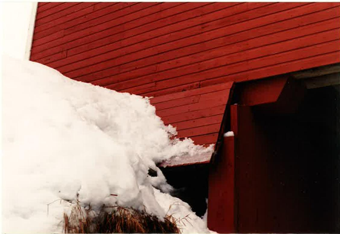
Les murs longitudinaux ont aussi un jet d'eau au-dessus des culées.
