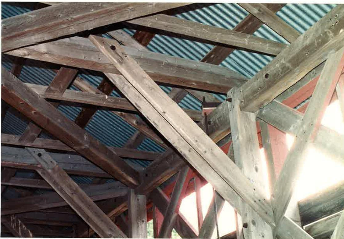
Structure du toit : croisillons et contrevents droits avec jambes de force. La tôle est posée sur des pannes clouées aux chevrons.
