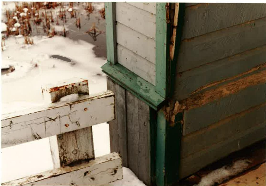
Sur les jambages, une planche inclinée sert de jet d'eau pour éloigner l'eau de pluie de la structure.
