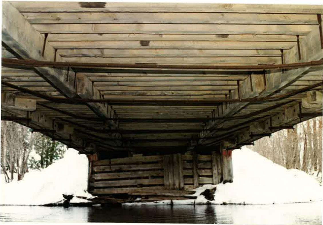
Vue sous le tablier du pont : Les poutres transversales sont supportées par les cordes inférieures et par deux poutres longitudinales soutenues par des tiges d'acier.
