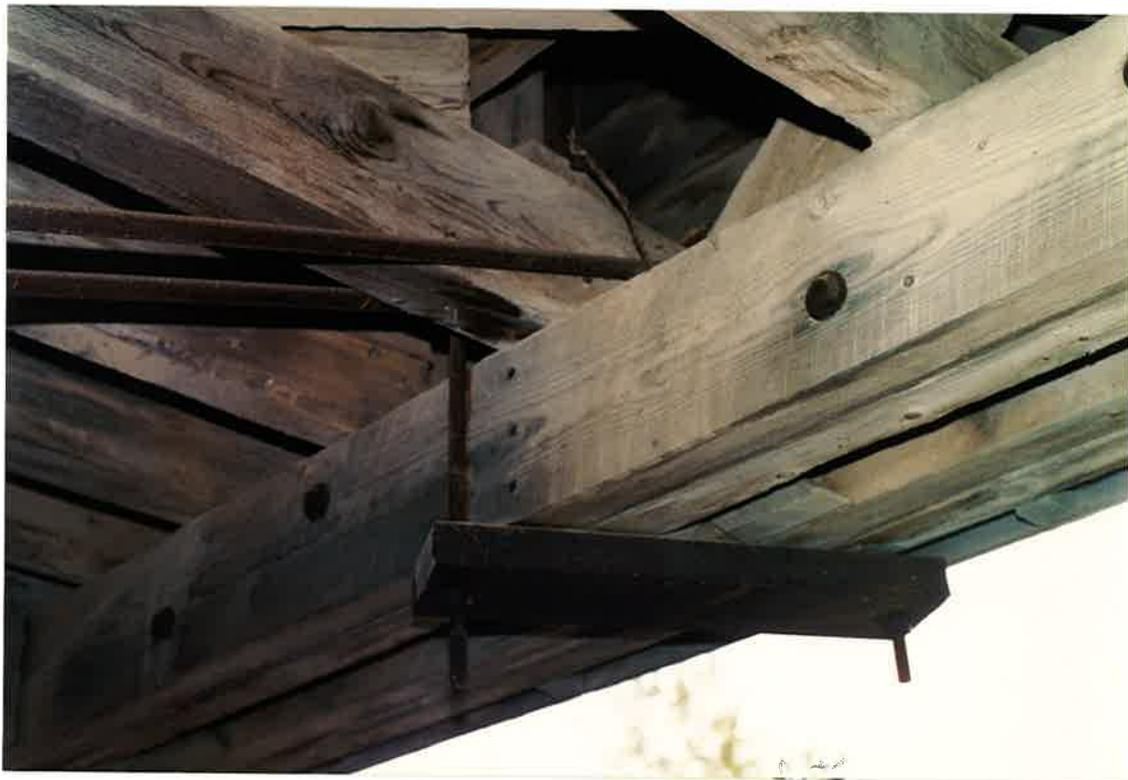
Les tiges de tension verticales supportent la corde inférieure et tiges horizontales soutiennent le tablier.
