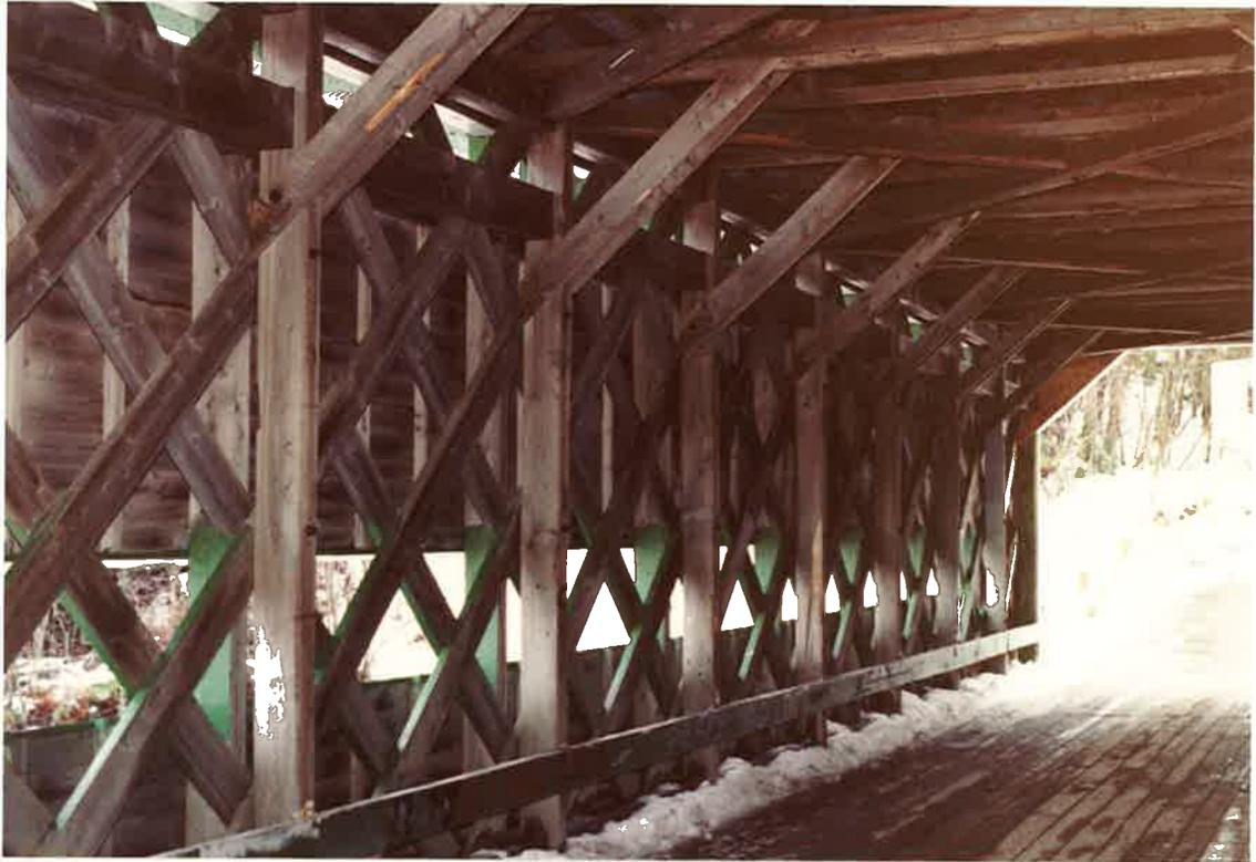
Structure des murs : treillis de madriers, poteaux verticaux et double corde supérieure.
