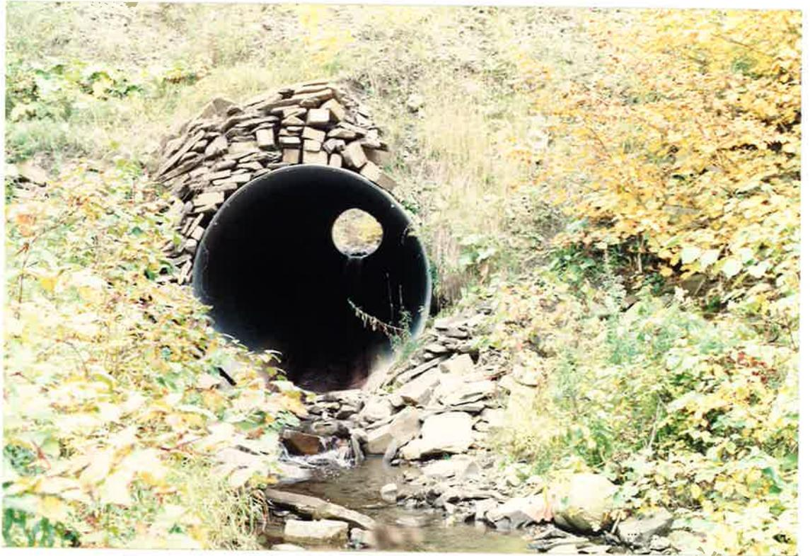
Le faible débit de la rivière du Brûlé a été canalisé dans un tuyau de métal posé sous la route qui passe à l'est du pont couvert.
