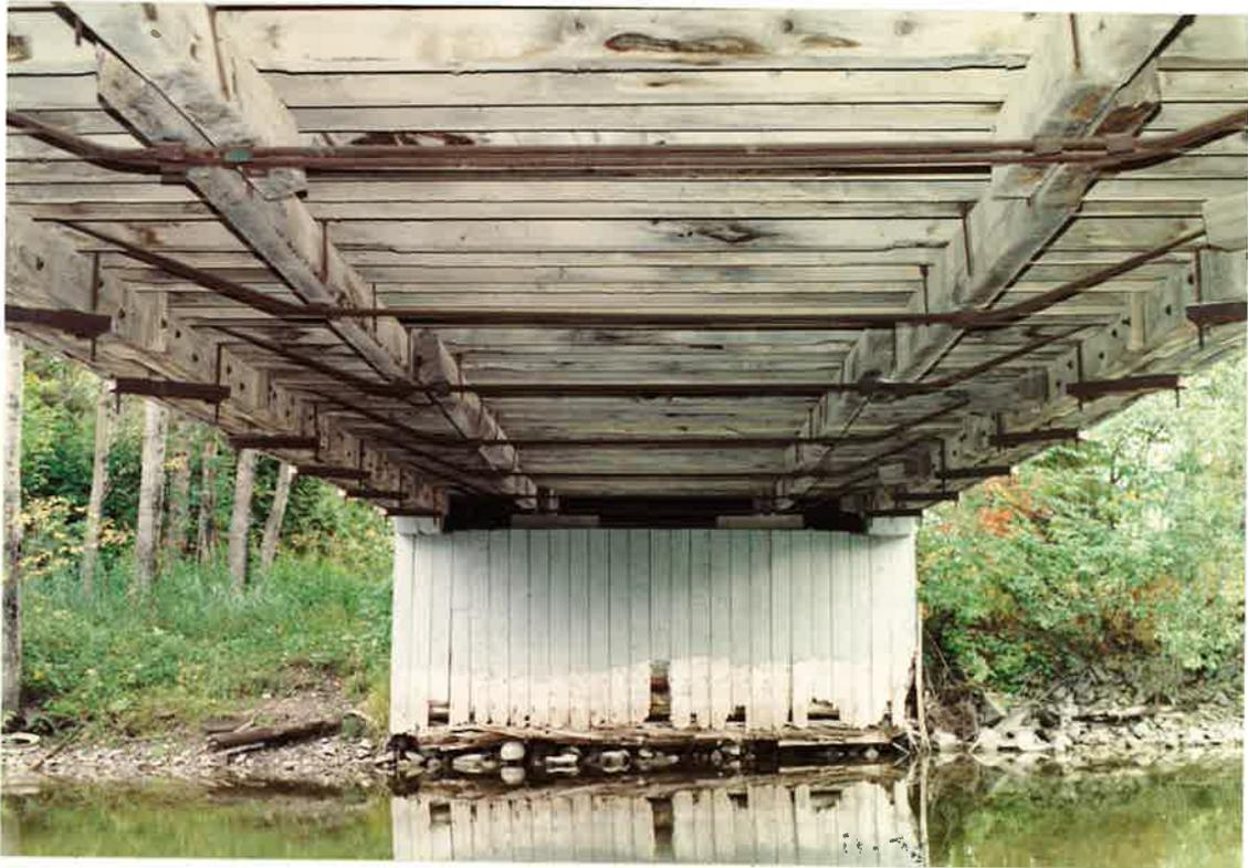
Tablier du pont de Saint-Anaclet. Les poutres transversales sont supportées par les cordes inférieures et par deux supports longitudinaux retenus par des tiges d'acier.
