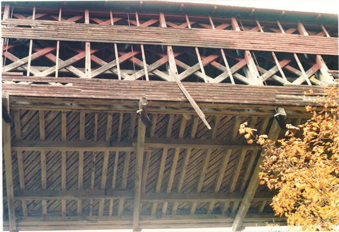
Pont Beauséjour : vue du tablier. Des poutres transversales soutiennent les cordes inférieures et les deux supports longitudinaux. Sur ces derniers, une série de poutres transversales porte des poutres obliques sur lesquelles sont posés les madriers du pavé.
